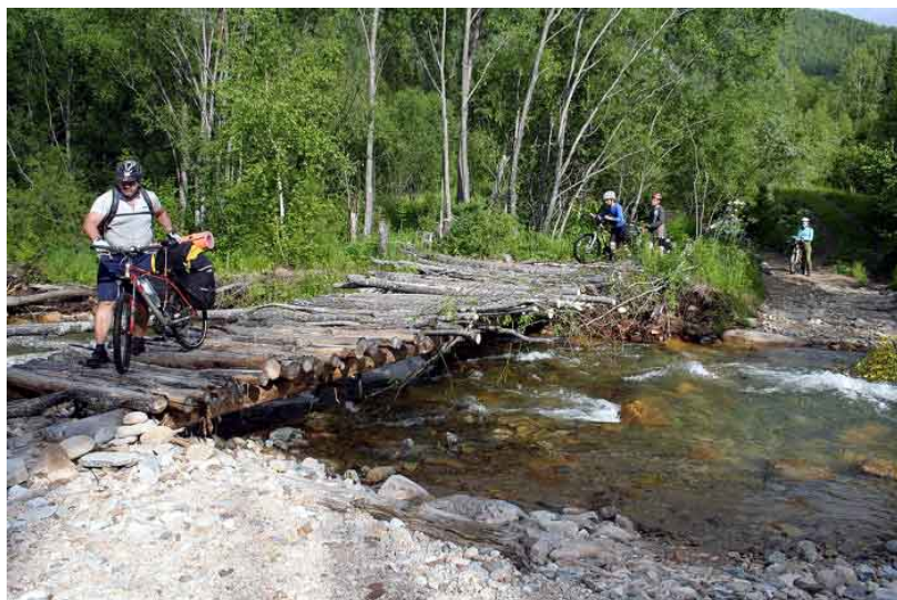
Фото. 25. Мост через р. Ниж. Березовая
