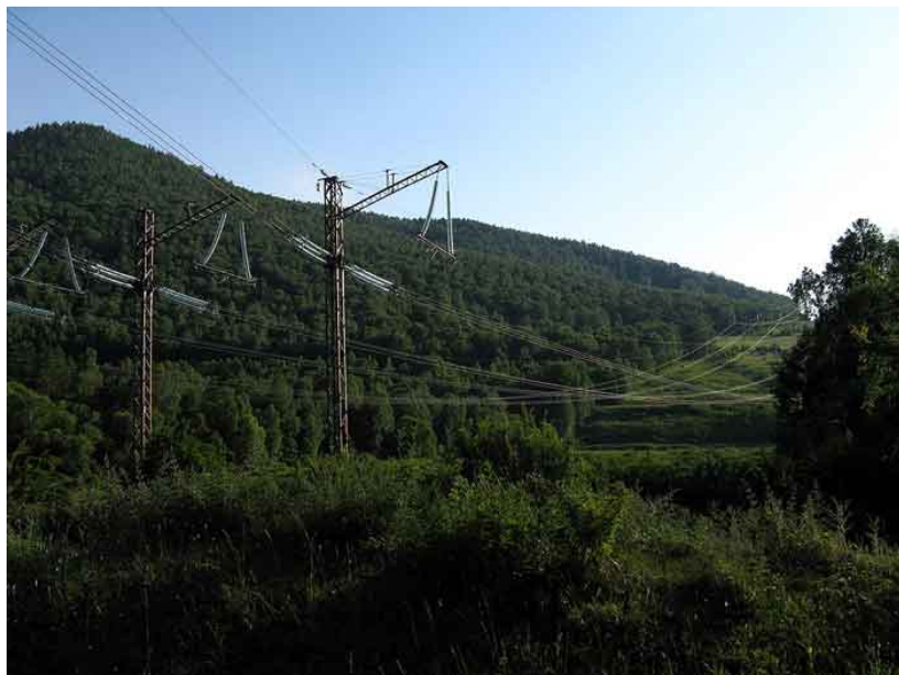
Фото. 58. ЛЭП идущая от СШГЭС недалеко от Табата
