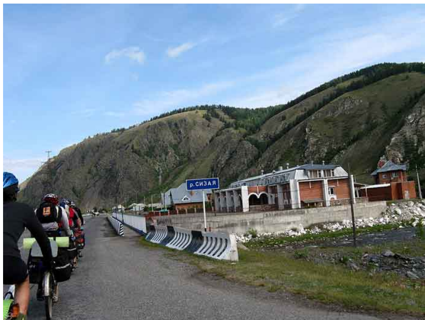
Фото. 82. Сизая, мост через одноименную реку
