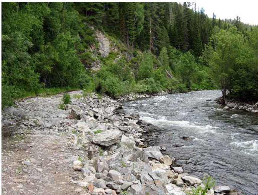
Фото. 24. Дорога по Теренсугу в 20 км от Балыксу
