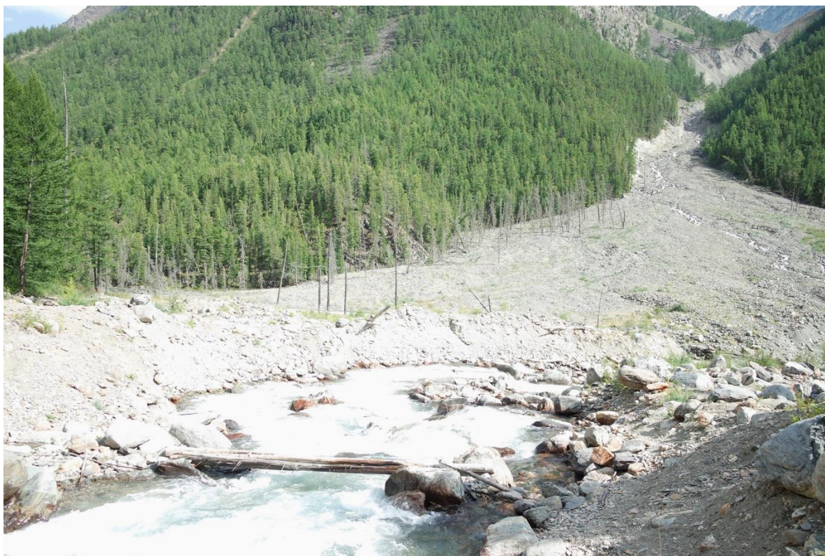
Фото 161. Мост через р. Камрю
